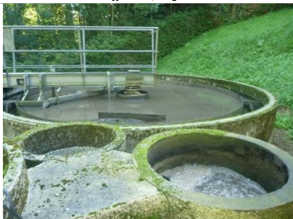
Bassin d'aération et puits à boues
